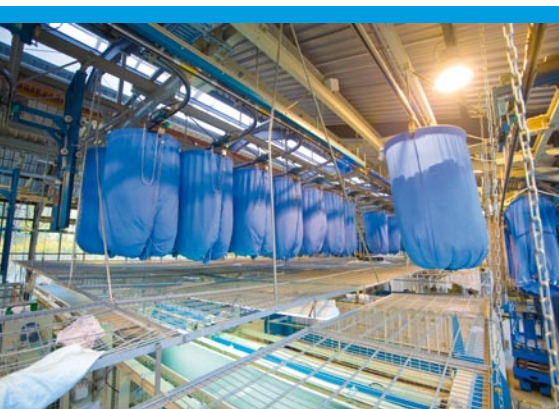
Das Hängebahnsystem ist die zentrale Versorgungssader für alle Wäschereibereiche.
